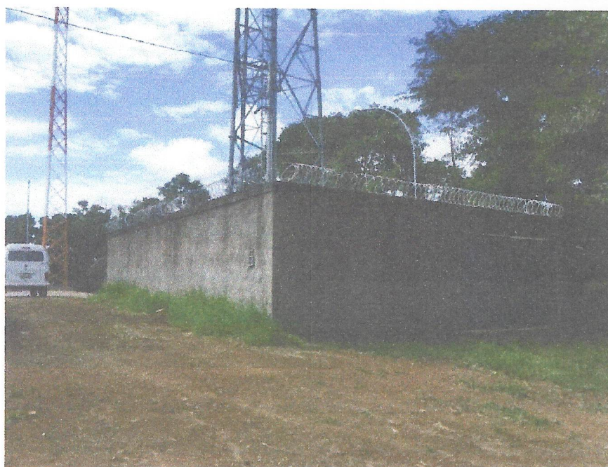
Figura 2: Área com o muro ao redor não faz parte da desapropriação
