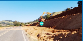
Concessionária EPR Sul de Minas faz construção de base operacional na MG 173.
